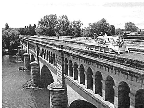
図 16 ベゼーの運河橋 Aquaduct
